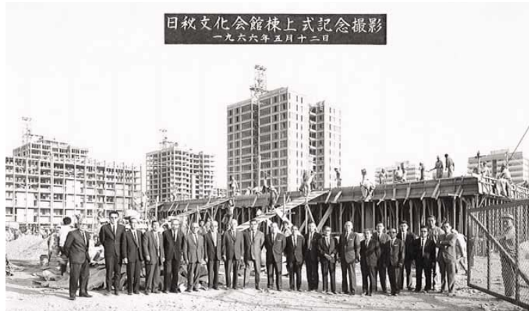
Directivos de la Sociedad Central Japonesa en el techado de la construcción del CCPJ, el 12 de mayo de 1966.
